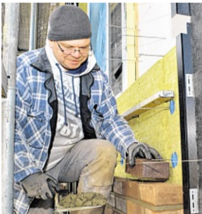
Gute Verarbeitung solider Materialien durch regionale Unternehmen: Hier Maurer Klaus-J. Miersen bei der Arbeit. RF
